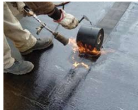
Mise en œuvre de la bande de pontage
