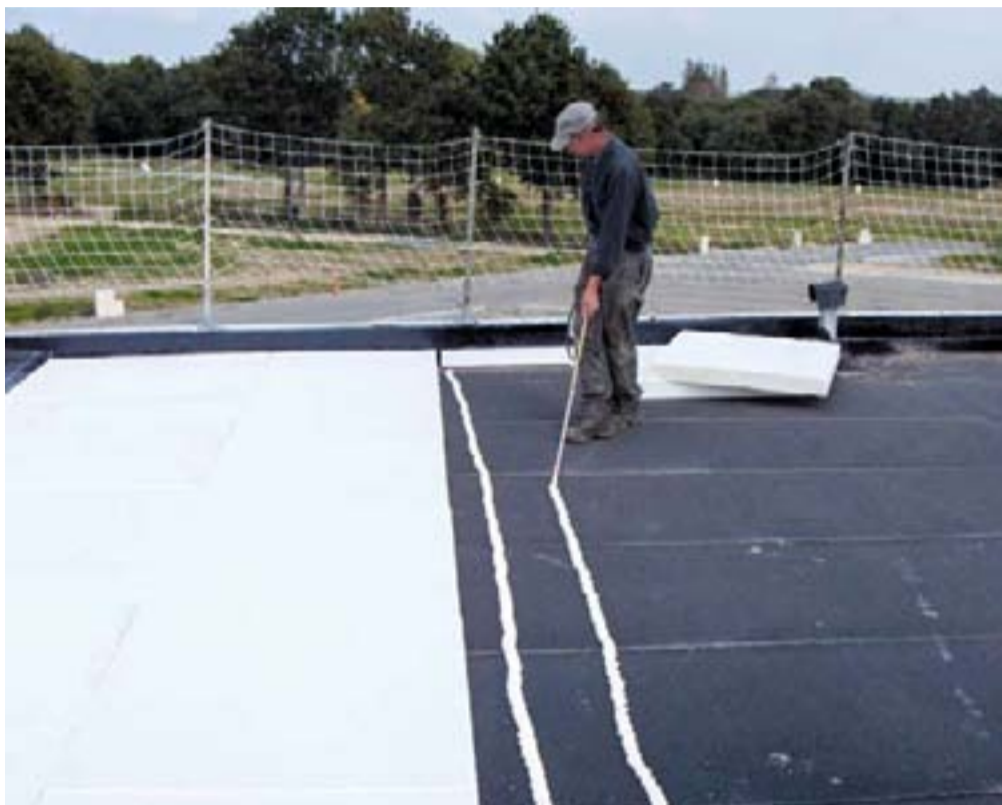
INSTA-STIK, la nouvelle colle d'Axter, permet la fixation à froid du PSE et de la laine de roche.
