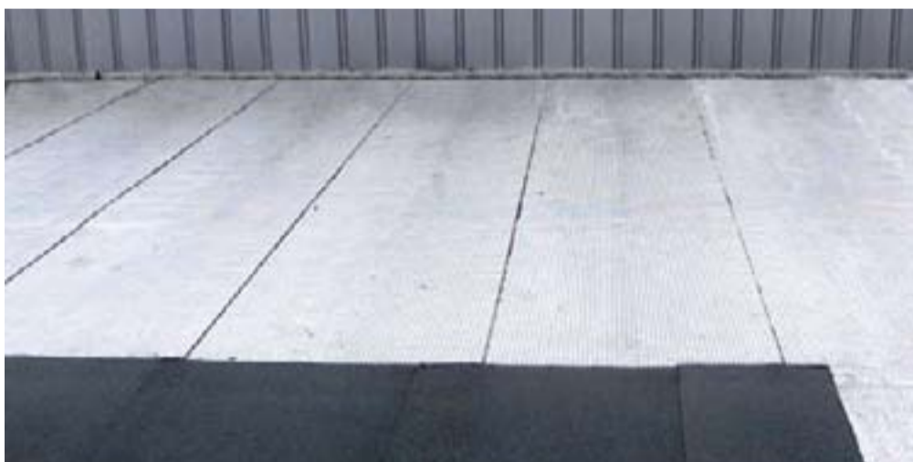
Adapté aux bâtiments à risque, ALPALU est spécialement conçu pour les murs coupe-feu, grâce à sa membrane d'étanchéité autoprotégée par feuille d'aluminium.
