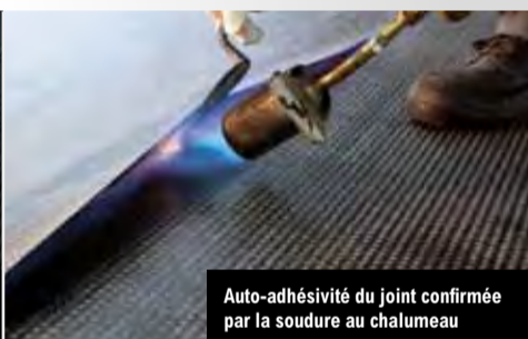
Membrane TOPFIX® FMP SPF fixée mécaniquement
