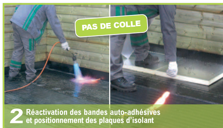
3 Mise en œuvre du procédé d'étanchéité
