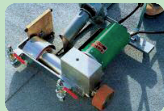
Figure 2 bis : mise en œuvre soudure à air chaud au droit du joint
