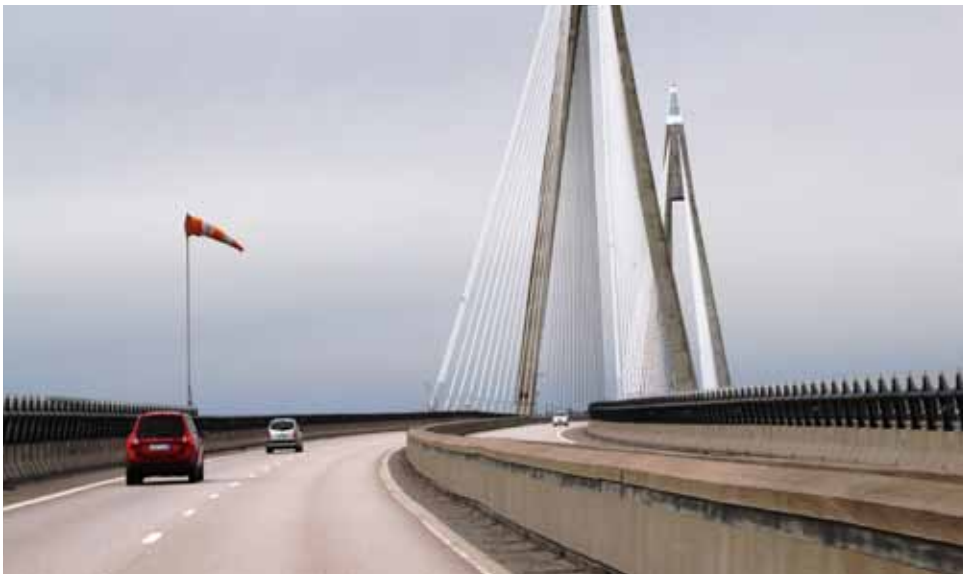
Sunnigesund Bridge Suède
